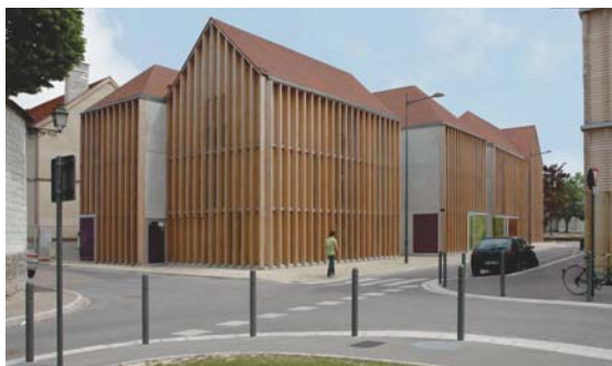
Logements étudiants Troyes Colomès et Nomdedeu, architectes
