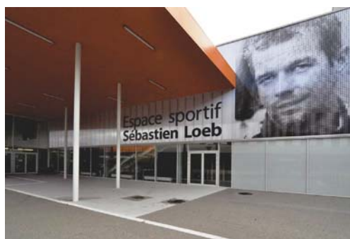
Centre Sportif Sébastien Loeb Haguenau Denu et Paradon, architectes
