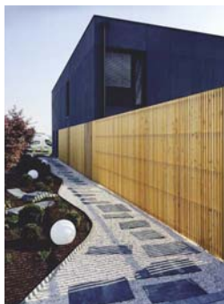
Maison passive Gueux Jean-Philippe Thomas, architectes
