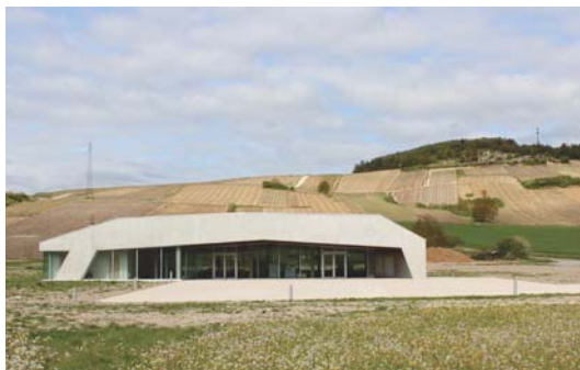
Salle polyvalente Neuville-sur-Seine Colomès et Nomdedeu, architectes
