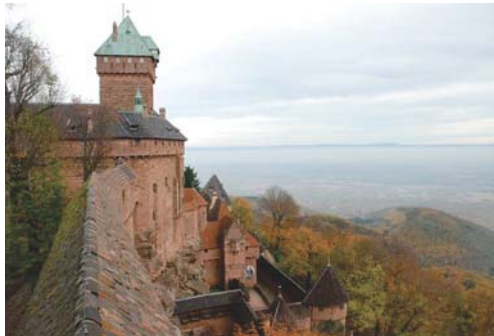
Château du Haut Kœnigsbourg Orschwiller Ebhardt, architecte
