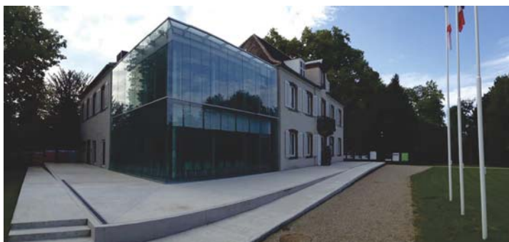
Lieu d'Europe Strasbourg Weber et Keiling, architectes
