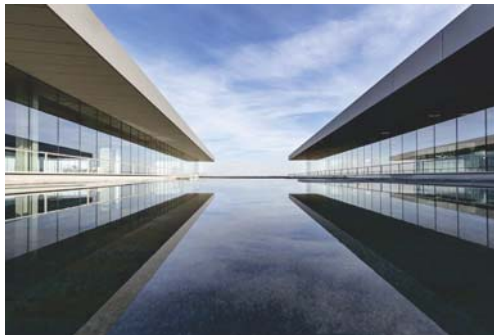
Chai du Champagne Moët & Chandon Oiry Giovanni Pace, architecte
