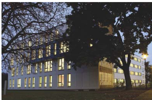
Siège de Mulhouse Habitat Mulhouse Formats Urbains, architectes associés
