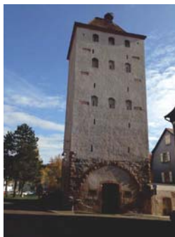
Porte d'entrée de ville Sélestat
